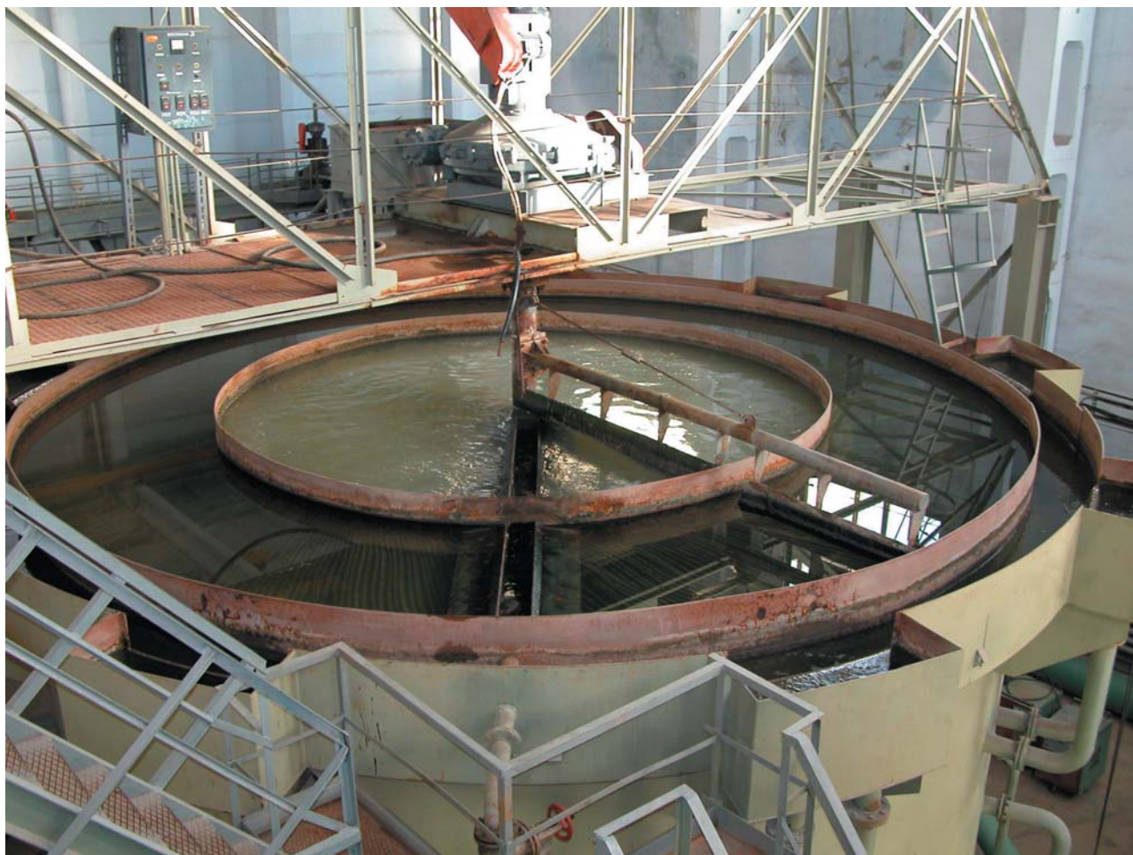
Отстойник-флокулятор
