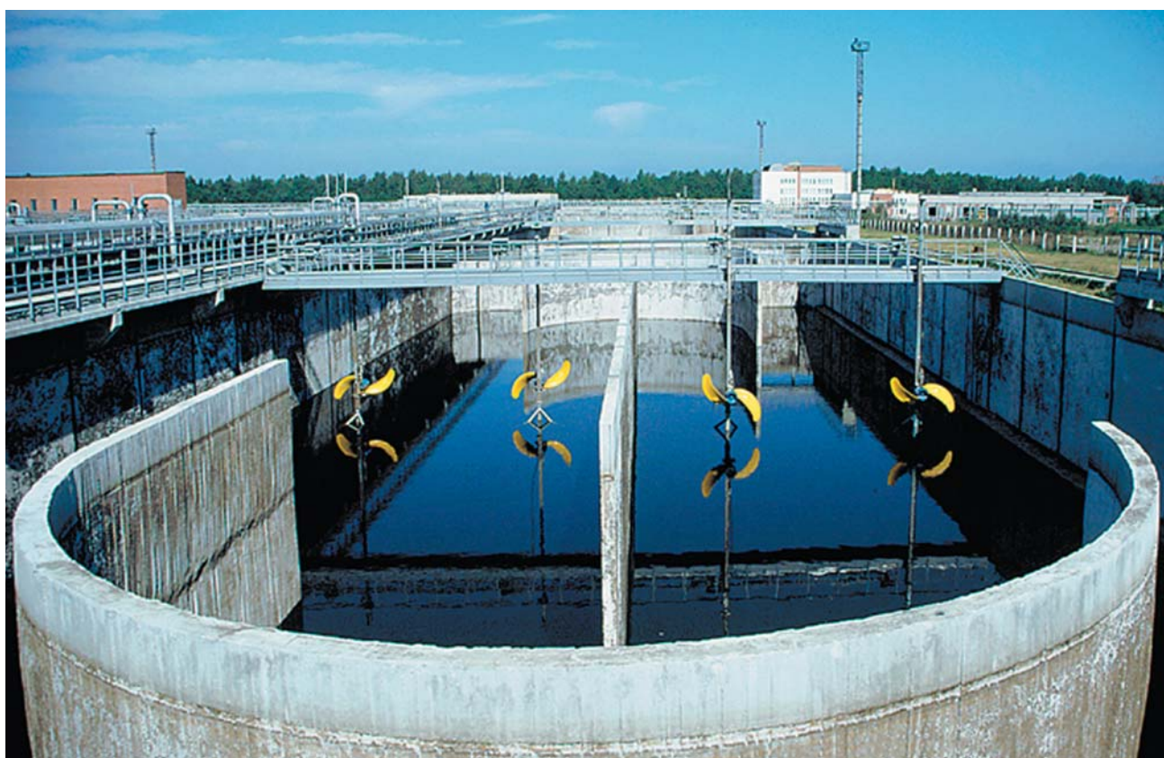
Натурные примеры продольной рециркуляции иловой смеси на очистных сооружениях: вверху — г. Вильнюс (зоны денитрификации); внизу — г. Рига (комбинированная зона симультанной нитрификации и денитрификации)
