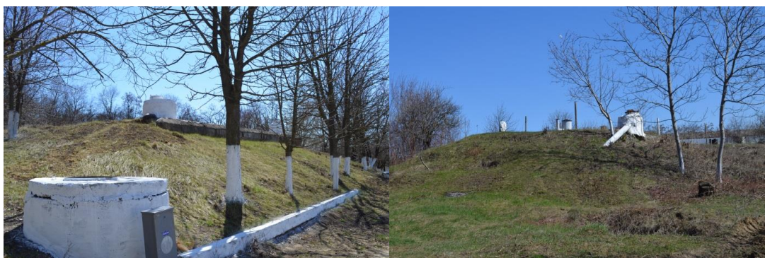
Figura 4-3: Rezervorul subteran de apă cu volumul 1.000 m 3 (teritoriul stației de pompare a apei SP-2) și cu volumul 300 m 3 (teritoriul stației de pompare a apei SP-3)
