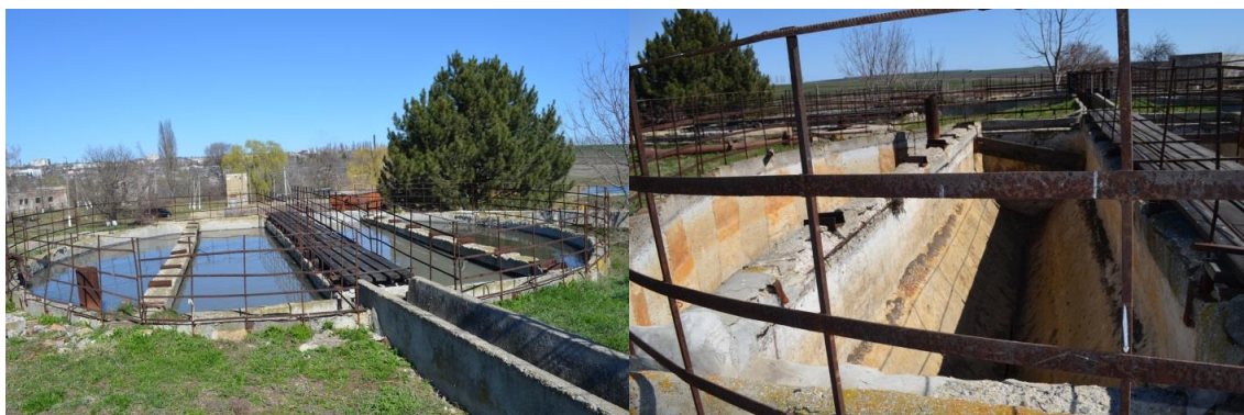
Figura 4-20: Stația de epurare a apelor uzate: Decantoare primare
