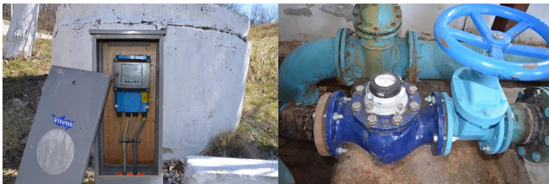
Figura 4-5: Stația de pompare a apei SP-2: nodul apometric care înregistrează volumul de apă brută la intrare și la ieșire din stație
