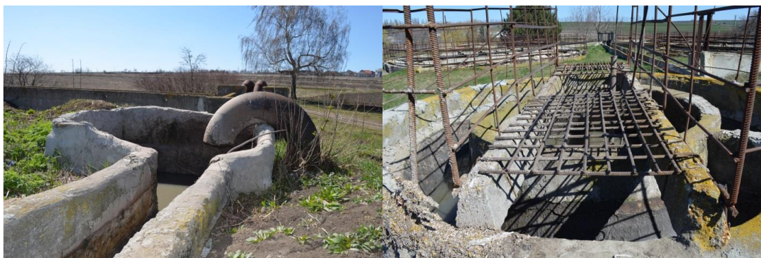
Figura 4-18: Stația de epurare a apelor uzate: Disipator de energie. Deznisipator
