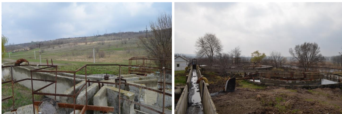
Figura 4-10: Stația de epurare a apelor uzate. Disipator de energie. Limpezitoare-fermentatoare
