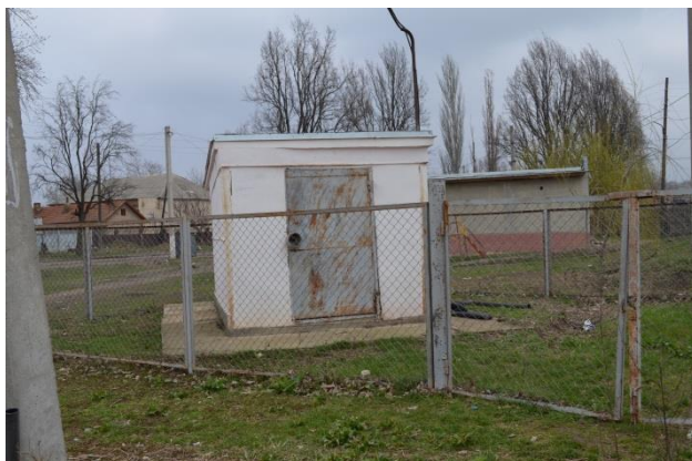
Figura 4-9: Stația de pompare a apelor uzate SPAU-1
