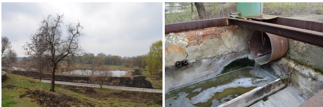
Figura 4-12: Stația de epurare a apelor uzate. Iazurile biologice
