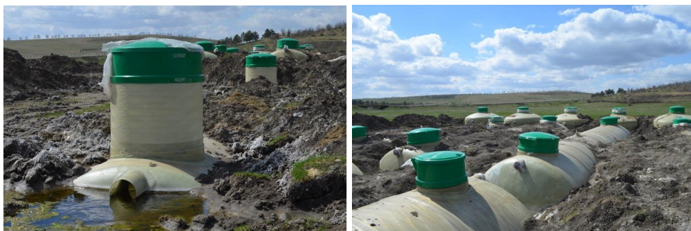
Figura 4-11: Stația de epurare a apelor uzate de tip container TRAIENIS (Lituania) în construcție
