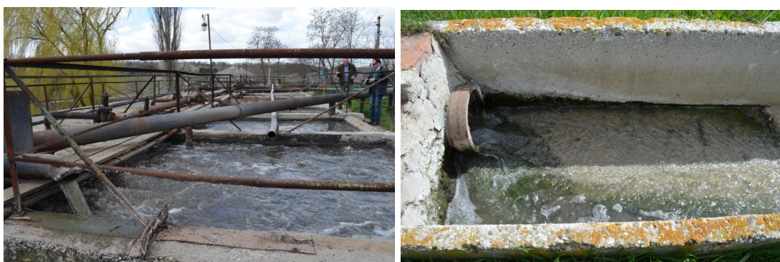
Figura 4-10: Stația de epurare. Bazinul de aerare cu nămol activ. Deversarea în râul Ciuluc
