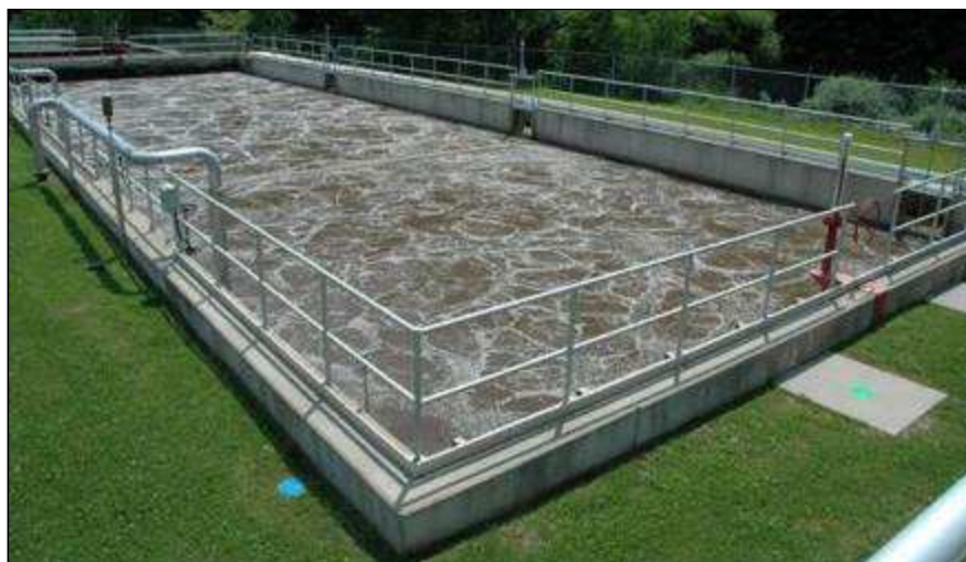
Figura 9-4: Rezervorul de aerare a nămolului aerat, Sursa imaginii: T. Simmons/Indiana University of Pennsylvania
