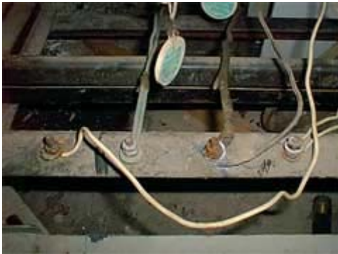
Ухудшение состояния контактных соединений в цепях нулевых рабочих проводников
