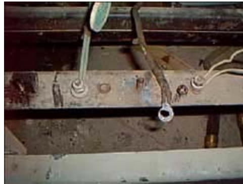
Ухудшение состояния контактных соединений в цепях нулевых рабочих проводников
