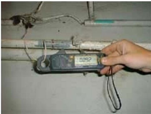
Четырехжильный кабель без нулевого рабочего проводника
