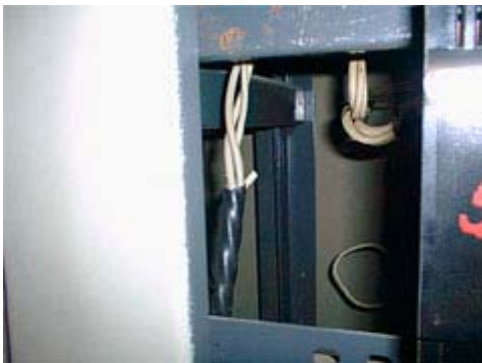
Четырехжильный кабель без нулевого рабочего проводника
