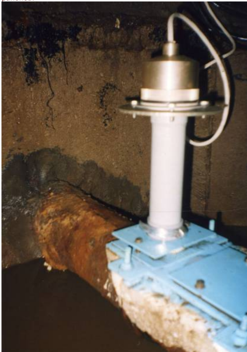
Фото 1. Установка акустического излучателя АП-13 на трубопроводе
