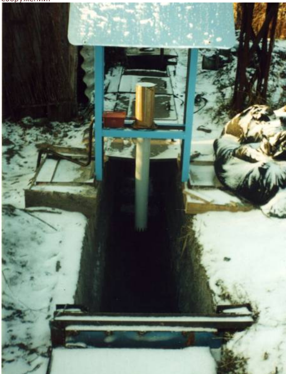
Фото 2. Установка акустического излучателя АП-11 на лоток
