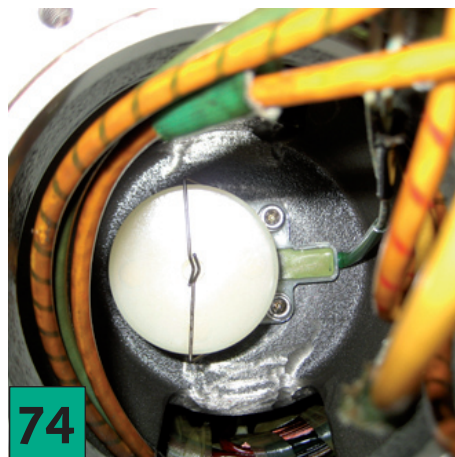
Ahora se puede ver el termointerruptor de flotador si éste existe.
