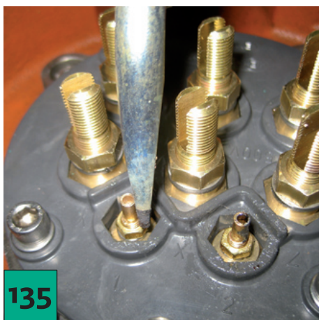
...caliéntelos con el soldador introduciendo estaño de soldar en el orificio,...
