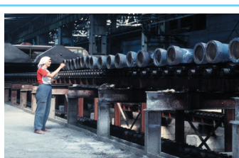
7. Участок нанесения цементно-песчаного покрытия
