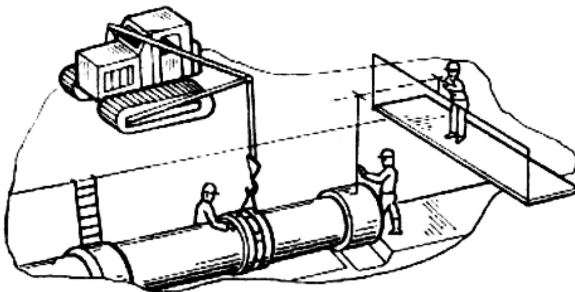
Рис.15. Выверка положения трубы по вертикали с помощью визирок
