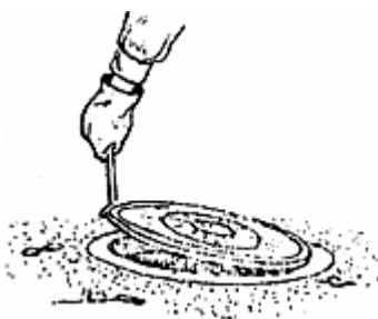
Рис.2. Открывание люка колодца
