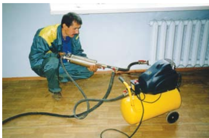
Очистка радиатора отопления
