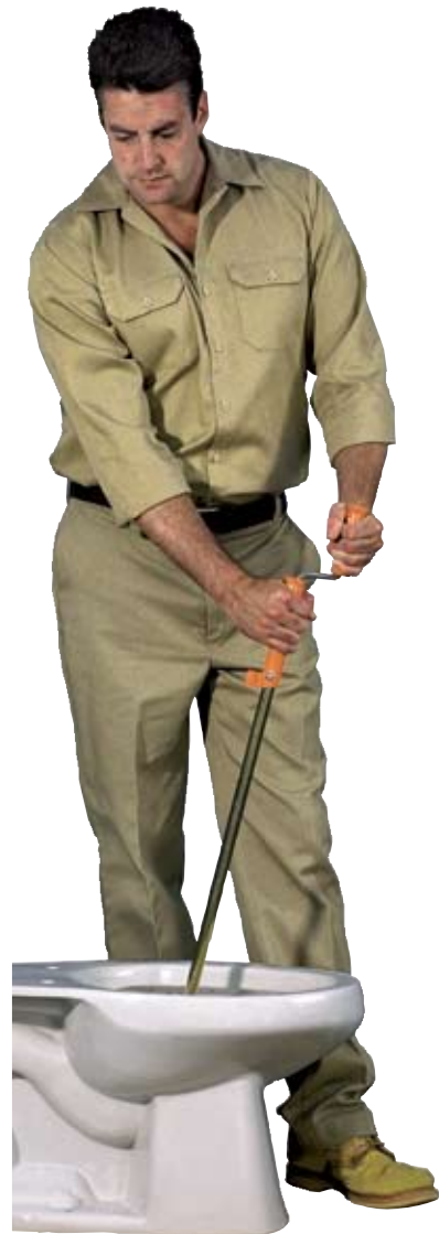
Прочистка засора унитаза
