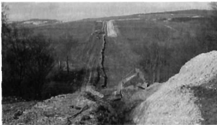
Рис. 3.34. Раскладка труб вдоль трассы
