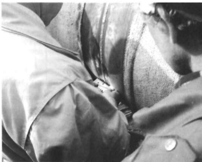
Рис. 5.5. Контроль сварного соединения шаблоном сварщика
