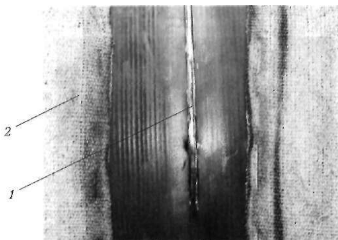
Рис. 3.46. Корневой шов, выполненный процессом STT: 1 — шов; 2 — термозащитный пояс, предохраняющий изоляцию
