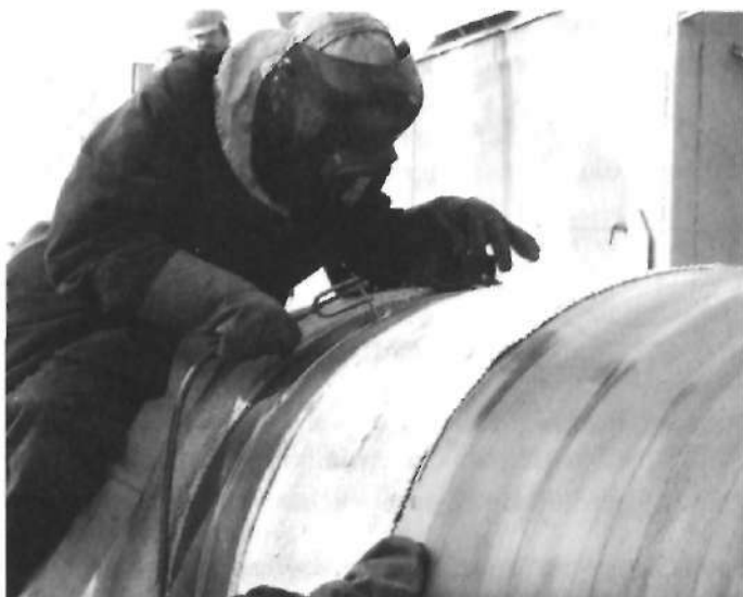
Рис. 5.4. Ручная электродуговая сварка
