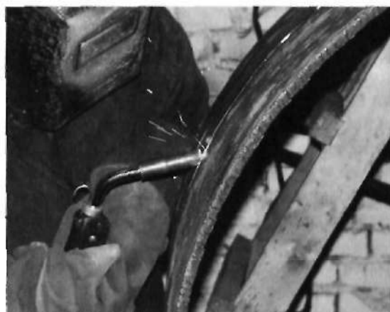
Рис. 3.48. Сварка процессом STT
