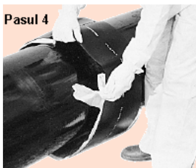
Fig.7.191 Îndepărtarea învelișului de protecție al colierului
