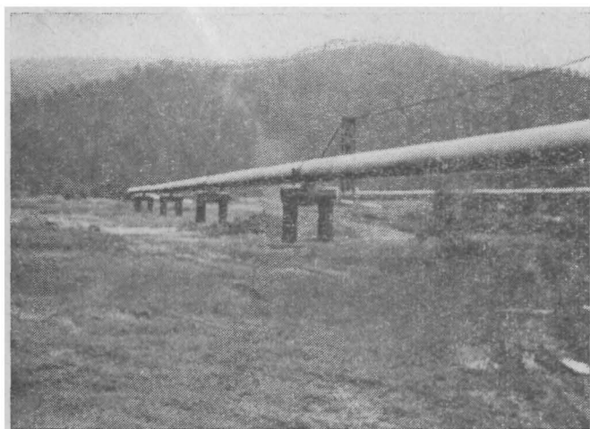
Рис. 46. Многопролетный балочный переход трубопровода в горных условиях
