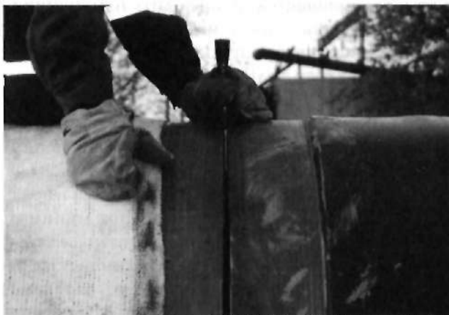
Рис. 3.69. Установка зазора
