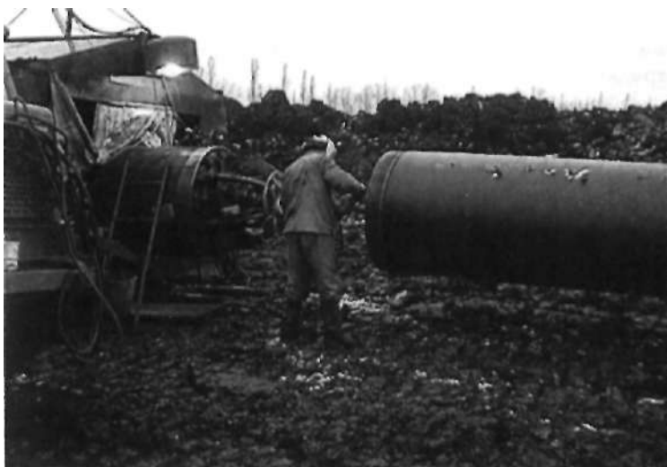
Рис. 2.3. Подготовка торцов труб и монтаж трубной секции
