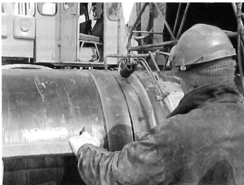
Рис. 2.4. Сушка кромок пропановой горелкой
