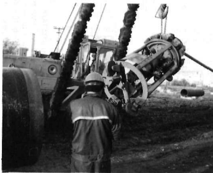
Рис. 3.29. Установка внутреннего центратора
