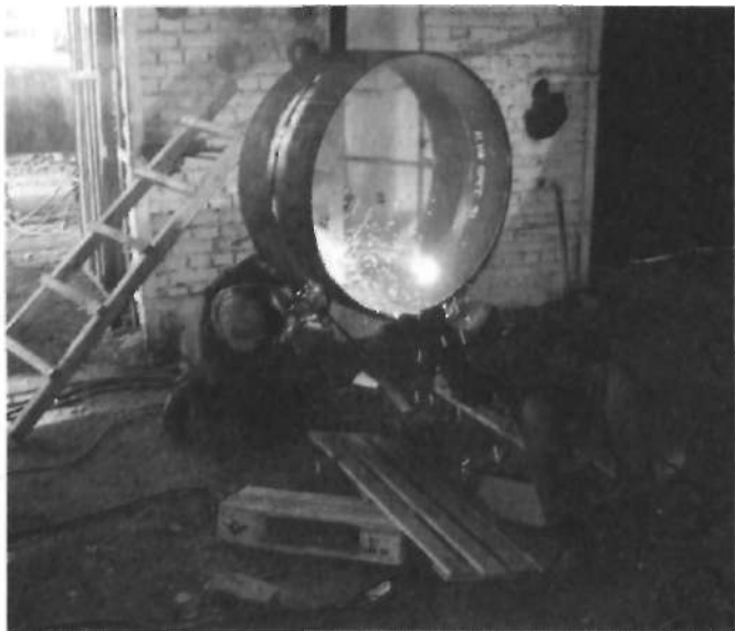
Рис. 5.3. Аттестация сварщиков — сварка кольцевого стыкового соединения
