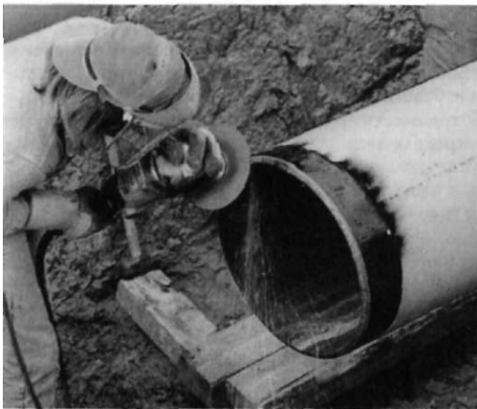
Рис. 2.1. Подготовка торцов труб к сварке
