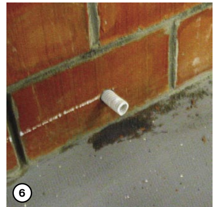
6 Устанавливаются гильзы из гофрированной трубы в отверстия стен и перегородок так, чтобы гильза выступала не менее, чем на 50 мм за грань конструкции
