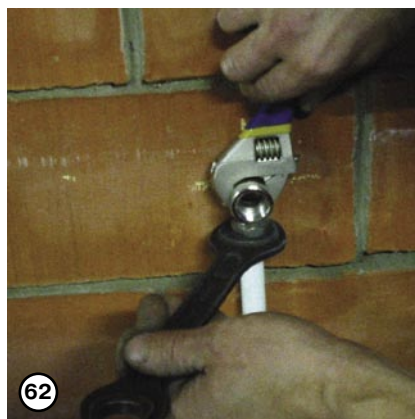
Можно монтировать обжимные фитинги с помощью разводных ключей или КТР («шведок»)
