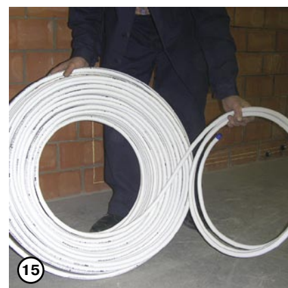
Отматывается необходимое количество трубы
