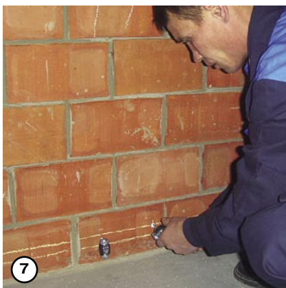
7 Устанавливаются неподвижные опоры
