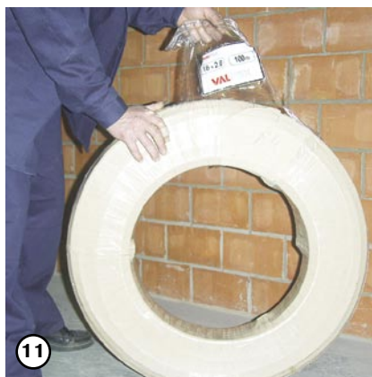
С бухты трубы снимаются полиэтиленовая упаковочная лента
