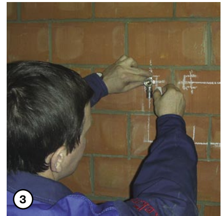
3 Намечаются места установки водорозеток
