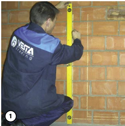
1 Разметка трассы трубопровода
