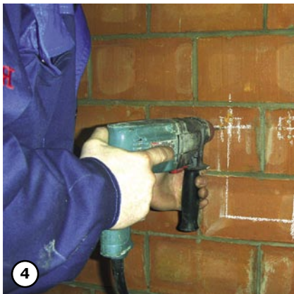
4 Высверливаются гнезда для крепления опор и водорозеток
