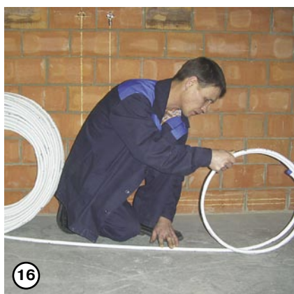
Вручную распрямляется отмотанный участок трубы
