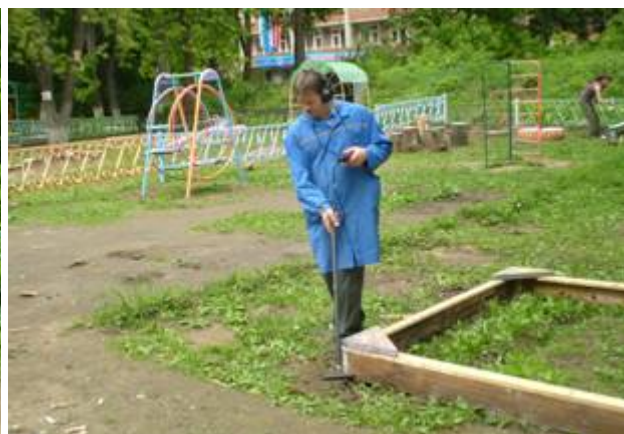
Обнаружены три трассы прокладки силовых кабельных линий. Два кабеля связывают, ВРУ-0,4 детского сада с ЩР-0,4 соседних учреждений.
