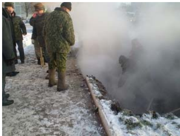
Уже в ходе работ по аномальному испарению с грунта был сделан вывод о близости утечки.
