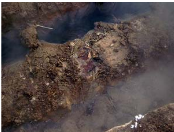
Уже в ходе работ по аномальному испарению с грунта был сделан вывод о близости утечки.
