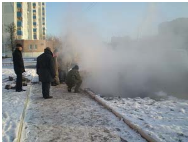
Уже в ходе работ по аномальному испарению с грунта был сделан вывод о близости утечки.
