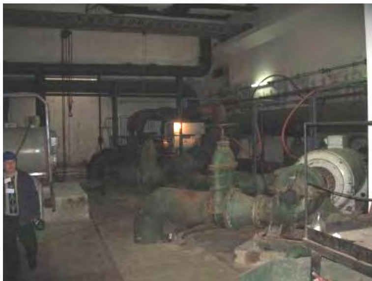
Figura 2.10-30: Stație de pompare la Uzina de apă Dărmănești – pompe vechi
