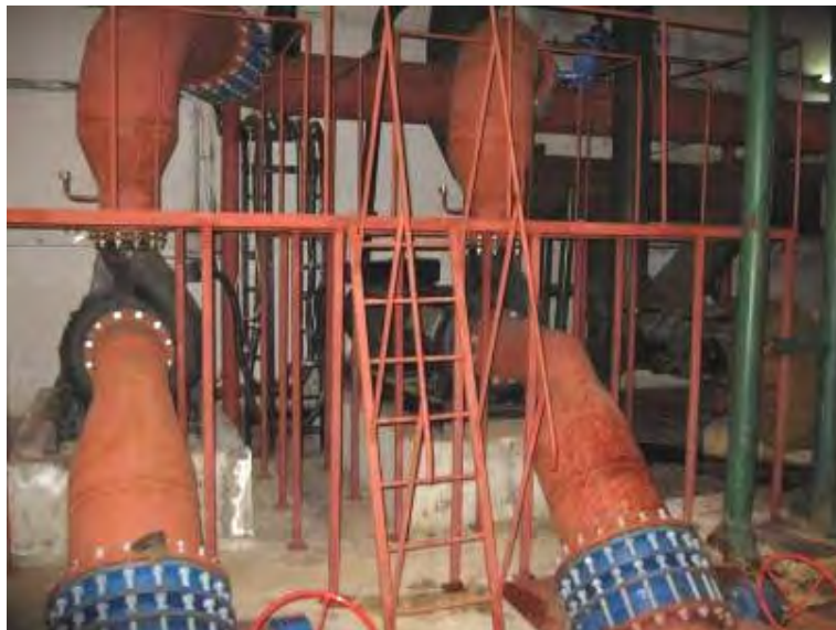
Figura 2.10-29: Stație de pompare la Uzina de apă Dărmănești – pompe noi, izolare insuficientă a pompelor
