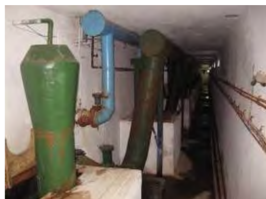
Figura 2.10-24: Galerie conducte filtre
