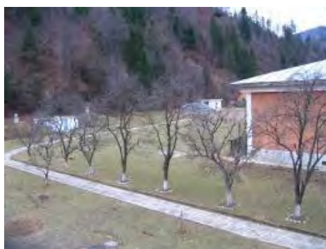
Figura 2.10-43: Sală filtre și rezervoare
