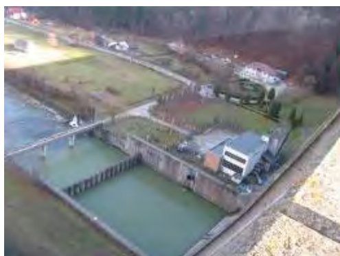
Figura 2.10-15: Vedere în aval de baraj
