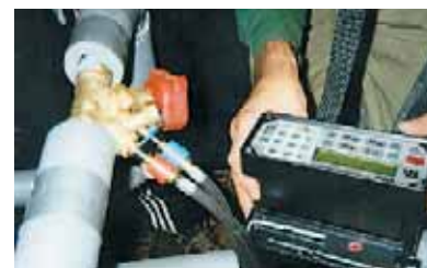
Рисунок 27. Балансировочный вентиль (слева) и проведение регулировки (справа)
