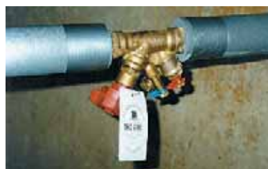
Рисунок 27. Балансировочный вентиль (слева) и проведение регулировки (справа)
