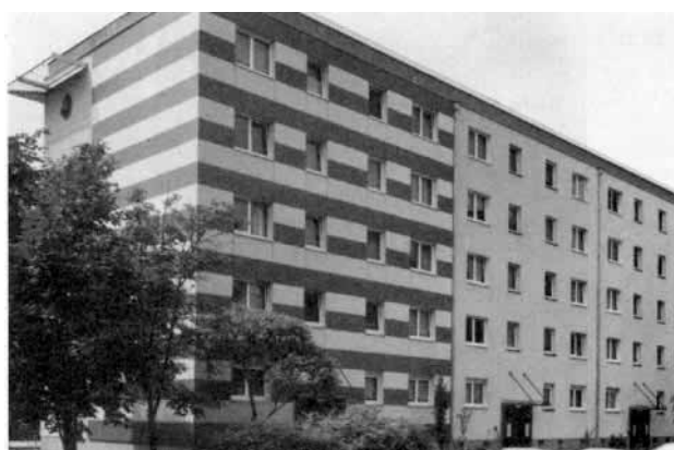
Рисунок 21. Панельное здание до (слева) и после (справа) реконструкции. Источник: A. Kerschberger et al, Modellhafte Sanierung von Typbauten, Verlag TÜV Rheinland, Köln 1998.
