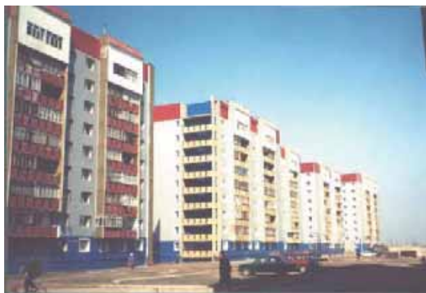
Рисунок 29. Наружное утепление стеновых конструкций в Оренбурге и наружное утепление арочного проема в Рязани
