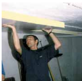
Рисунок 10. Теплоизоляция потолка (слева) и пола (справа) в подвале
