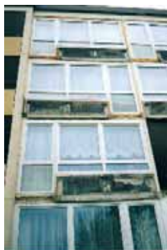
Рисунок 11. Ликвидация температурных мостков за счет удаления отдельных элементов (в данном случае — горшки с цветами) перед проведением теплоизоляции стен.
