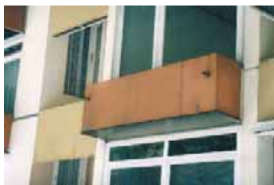
Рисунок 11. Ликвидация температурных мостков за счет удаления отдельных элементов (в данном случае — горшки с цветами) перед проведением теплоизоляции стен.
