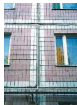
Рисунок 30. Уплотнение межпанельных швов в Рязани
