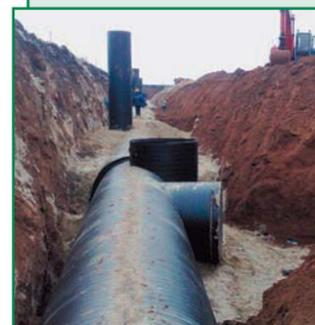
Система для ливневой и технической канализации “СПИРОЛАЙН” производится из полиэтилена и включает трубы, фитинги, колодцы, КНС, резервуары и различные нестандартные изделия. Смонтированная система полностью однородна (нет уплотнительных колец), герметична и держит малый напор (может использоваться как временный накопительный резервуар для ливнестоков), не имеет выступающих элементов – раструбов (преимущество при санации).
