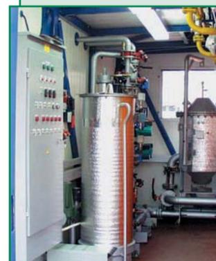
Котельные "АКМА" модульной компоновки в контейнерном исполнении с высокими техническими параметрами, теплопроизводительностью от 0,5 до 3,0 МВт, на базе высокоэффективных и экологичных котлоагрегатов серии УТМ.
