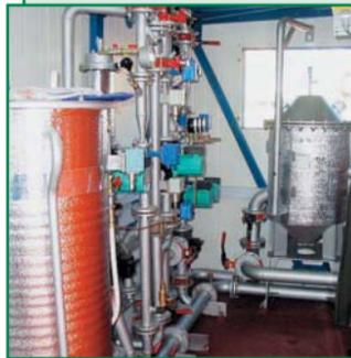
Предназначен для обработки внутрисетевой воды в системах отопления и ГВС с целью предотвращения образования накипи в водогрейных котлах и теплообменниках.
