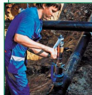
Оборудование для врезки под давлением применяется для подсоединения новых трубопроводов без отключения потребителя.
