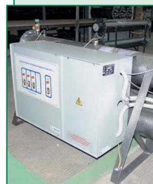
Электроводонагреватели проточные класса “Стандарт-эконом”, серия ЭПВН мощностью от 7,5 до 30,0 кВт. Электроводонагреватели проточные класса “Профессионал”, серия ЭПВН мощностью от 36 до 120 кВт. Предназначены для горячего водоснабжения жилых, бытовых, производственных помещений в качестве основного или резервного источника горячей воды. Производительность при разнице температур в 35 °С – от 180 до 3 000 л. КПД прибора – 93%.
