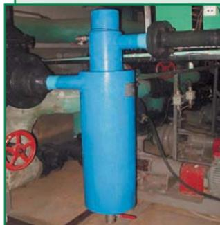
Технология NORMAQUA для защиты и очистки бойлеров, пластинчатых теплообменников, водогрейных котлов от накипи, в т. ч. от воды с нарастающей жесткостью. Заменяет станции химводоподготовки, обезжелезивания, деаэрации.
