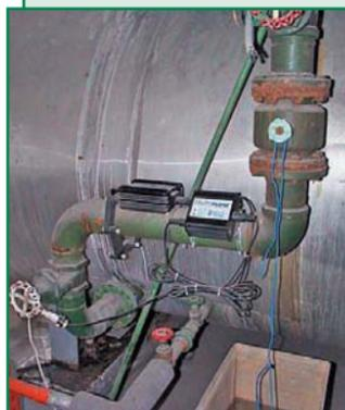
Противонакипные устройства Гидрофлоу серии "С" предназначены для защиты от накипи, отложений различной природы, внутренней коррозии котлов, бойлеров, теплообменного оборудования, систем обратного водоснабжения.
