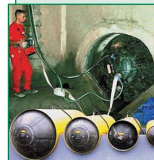
Пневматические заглушающие перекрытия применяются для перекрытия труб сечением от 80 до 2 800 мм. Многофункциональны. Применяются в системах дождевой и производственно-бытовой канализации при ремонте, инспекции, санации, испытаниях трубопровода на герметичность.
