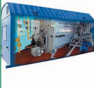
Применение в котельных установках надежного современного вспомогательного оборудования позволило полностью автоматизировать все технологические процессы и обеспечить безопасность ее обслуживания.
