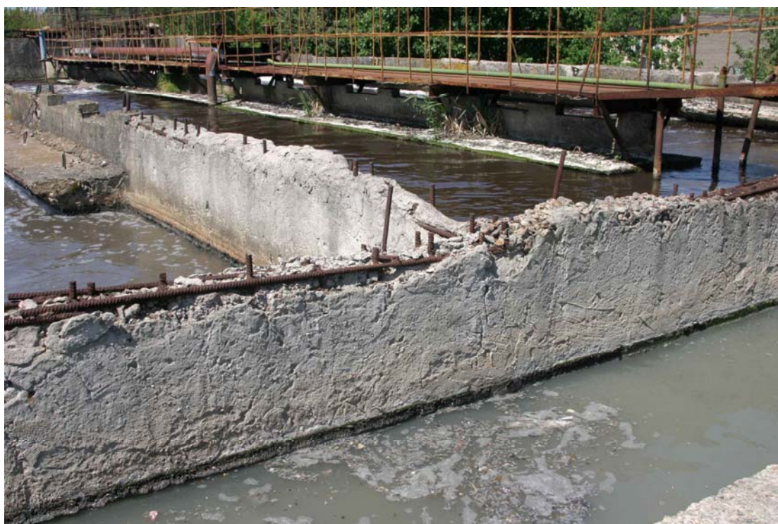
Проржавевшая задвижка в разъединном бетоне на станции по очистке воды активным илом
