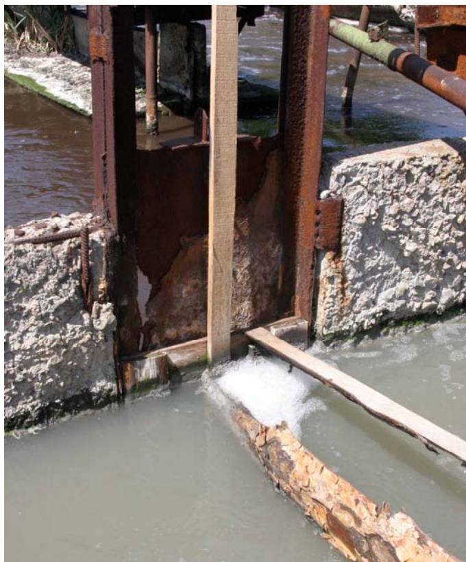
Проржавевшая задвижка в разъединном бетоне на станции по очистке воды активным илом
