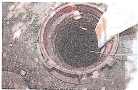
Рис. 3.7. Подача защитной оболочки в трубопровод через открытый люк колодца
