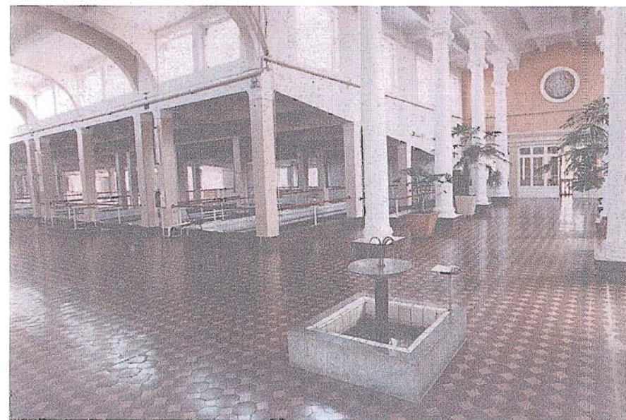
Зал фильтров Северной водопроводной станции
