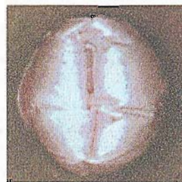
Рис. 3.10. Фрагмент выворота чулка в период санации трубопровода
