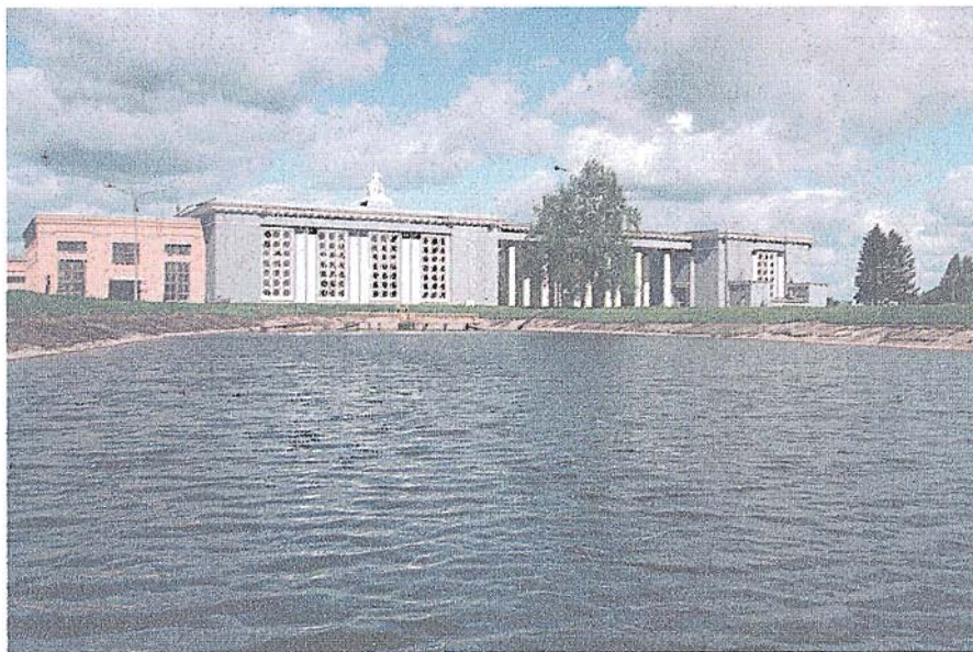
Водопроводный ковш Восточной водопроводной станции
