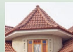
Пластиковая кровельная черепица, изготовленная из рециркулированных материалов в Украине.
