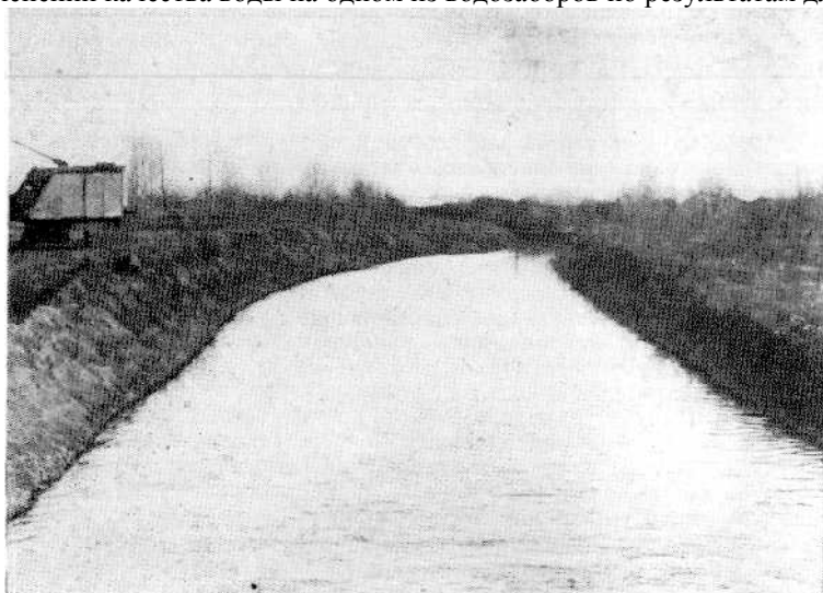
Рис. 80. Инфильтрационный канал на водозаборе из р. Томь
