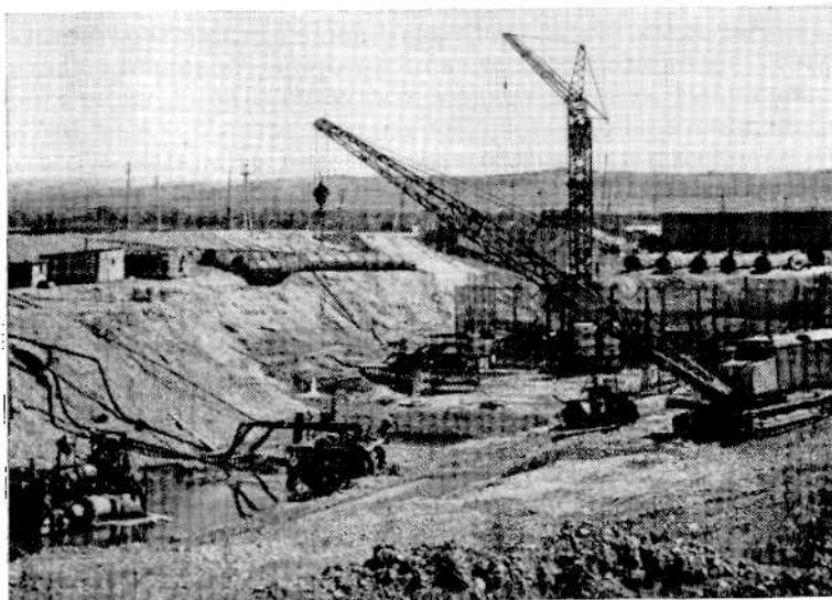
Рис. 6. Строительство ковшового водозабора на р. Томь
