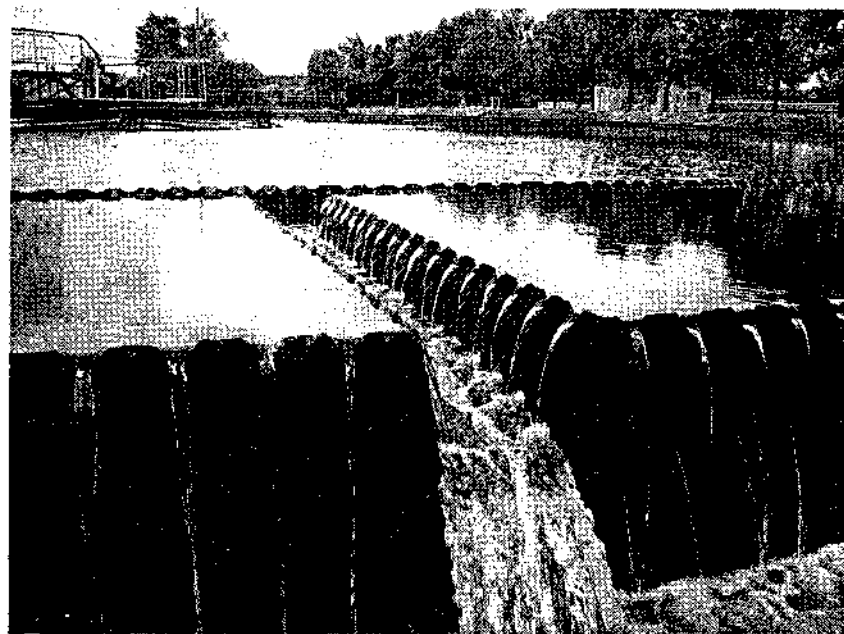
Рис. 6.3. Устройство зубчатого водослива
