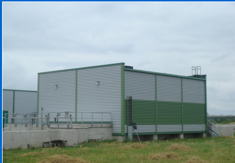
Юго-Западные очистные сооружения, г. Санкт-Петербург 330 000 м 3 /сут
