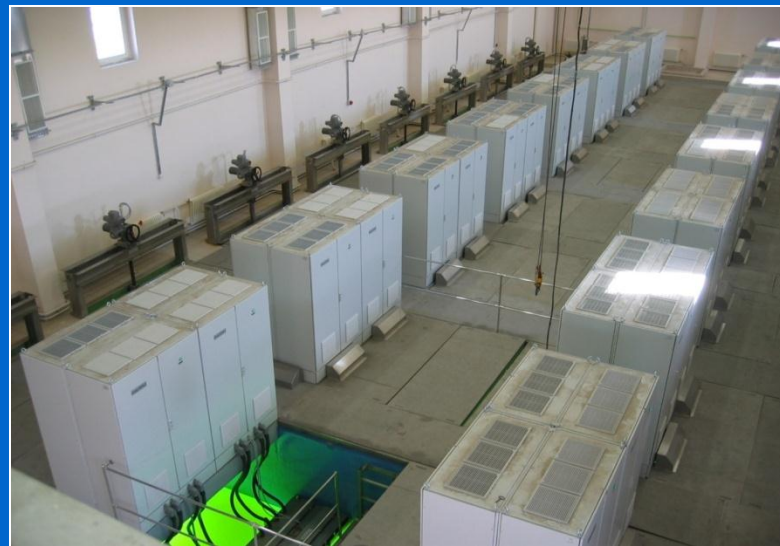
Люберецкие очистные сооружения , г. Москва 1 000 000 м 3 /сут
