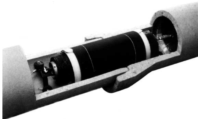
Рис. 8. Фрагмент ремонтного участка трубопровода с установленной в нем ремонтной гильзой Grouting Sleeve.
