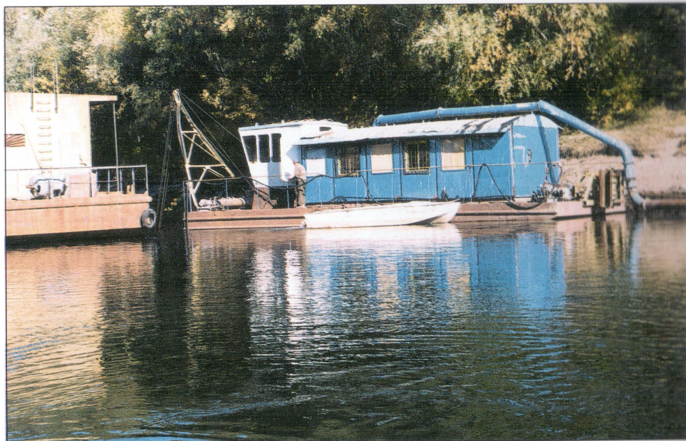
Curățarea căușului de la stația de pompare de treapta I cu utilajul de săpat pământul. Очистка ковши насосной станции I подъема земснарядом.
