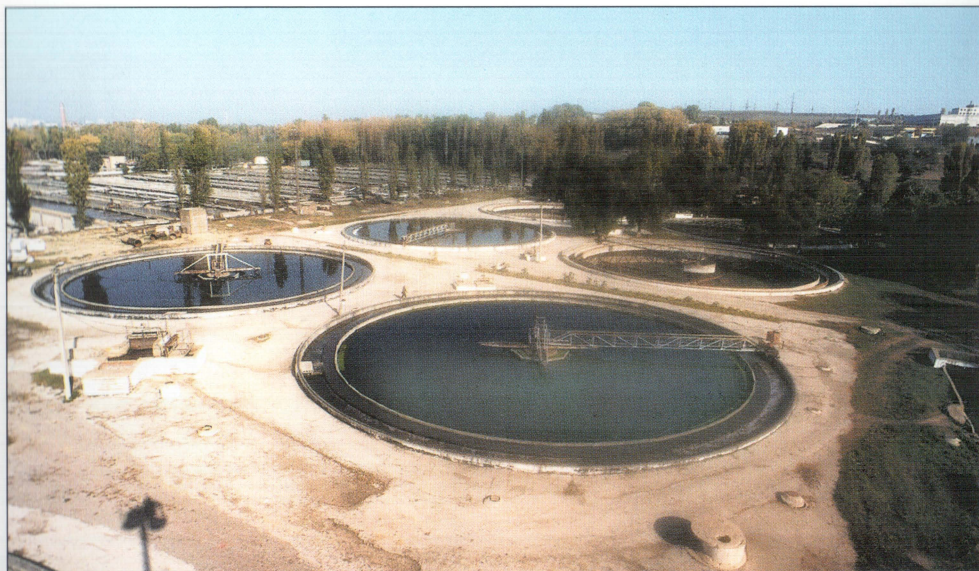
Stația de epurare biologică a apelor uzate. În prim plan – decantoarele radiale. Станция биологической очистки стоков. На переднем плане – радиальные отстойники.
