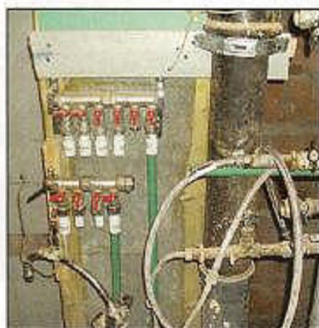
В новых домах обычно делают коллекторную разводку с использованием так называемой «гребёнки».
