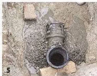
Установка колена для монтажа трубы стояка.
