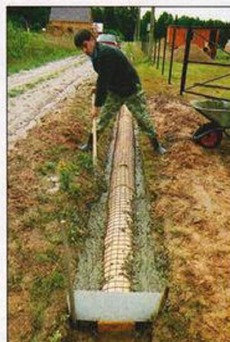
На заливку свода ушло несколько тачек бетона.
