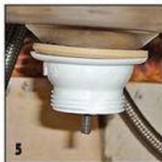
...с помощью которого крепим выпускной патрубок сифона.
