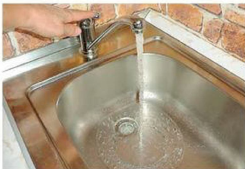
Финишная операция, которую выполняют после установки нового сифона. Открыв кран с водой, проверяем все соединения сифона на течь.
