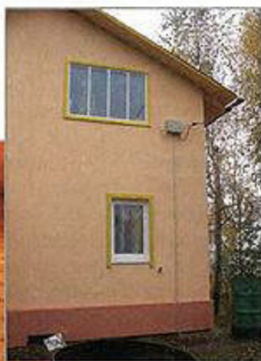
Один из вариантов дополнительной защиты на вводе — установка на наружной стене дома автоматического выключателя.
