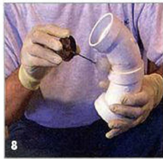
Заполните пустоты. После того, как клей в месте соединения затвердел, нанесите на раструб тонкий слой клея, чтобы заполнить все оставшиеся пустоты.
