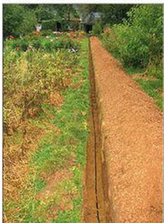
Траншею для укладки кабеля под землей копают на глубину 0,7 м. На её дно насыпают песок слоем 10 см.
