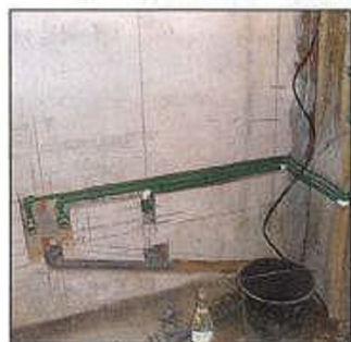
Разводку холодного и горячего водоснабжения сегодня довольно часто выполняют полипропиленовыми трубами.
