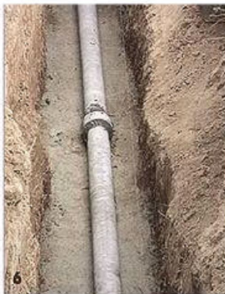
Укладка труб в траншею.
