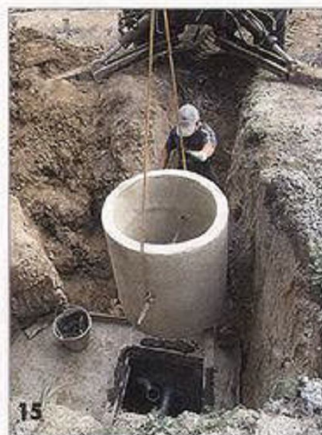
Монтаж колец над септиком.
