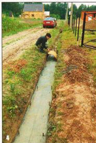
При заливке бетона замонолитили отрезки арматуры, чтобы связать стенки трубы с основанием.
