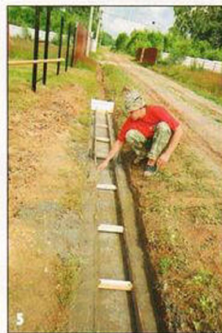
Ширины фанерных полос не хватало для формирования полноценного арочного свода, поэтому стенки трубы «подняли», залив пару полосок бетона.
