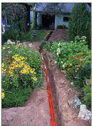
Если точное размещение кабеля зафиксировано на плане участка, допустимо над кабелем положить только специальную сигнальную ленту.
