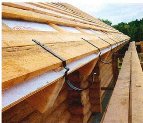
Держатели желобов установлены.
