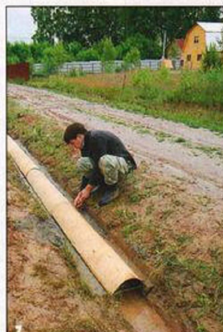
Когда фанерную опалубку установили на место, въезд на участок уже стал приобретать зримые черты.
