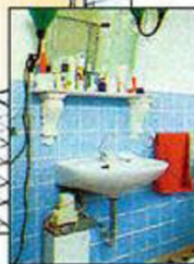
Рис. 9. Самодельная тумба укрывает проточный водонагреватель и сливную арматуру. Снаружи к боковым стенкам тумбы можно прикрепить ещё и полотенцедержатели.
