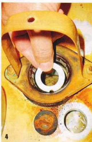
Гайку для крепления переливной трубки заводим под отверстие перелива через седло колонки сливного бачка.
