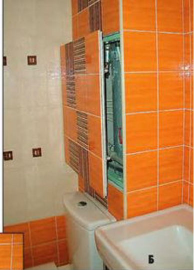
Глядя на стены ванной комнаты (фото слева), не скажешь, что где-то здесь есть люк для доступа к сантехническим приборам.
