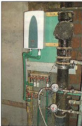
Установка проточного нагревателя AEG.
