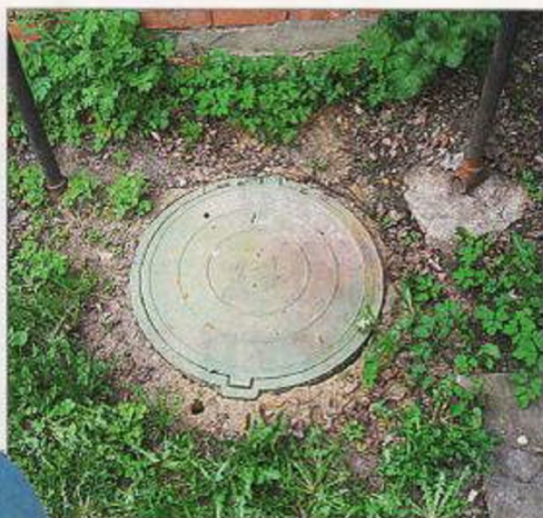
Крышка фильтрующего колодца для отвода стоков.
