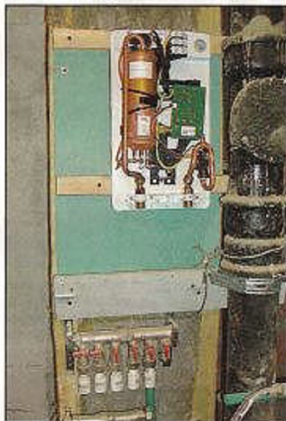
Установка проточного нагревателя AEG.
