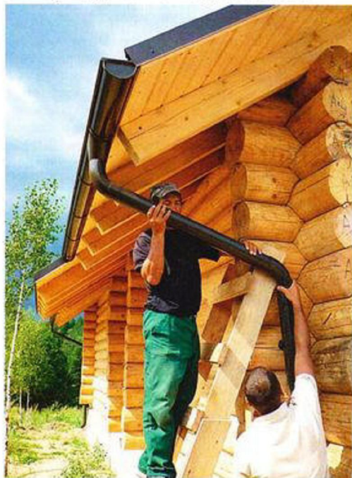
Монтаж водосточных труб.
