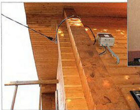
Один из вариантов дополнительной защиты на вводе — установка на наружной стене дома автоматического выключателя.
