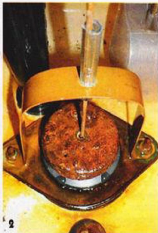
Устанавливаем сверху на «грушу» металлический диск. Этот груз позволяет и частично сливать воду из бачка.
