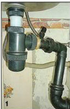
При замене сифона убираем всю старую подводку от мойки до раструбы канализационной трубы. Тем более, что патрубок для подключения сливного шланга стиральной машины в дальнейшем не понадобится.
