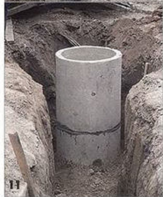
Монтаж перепадного колодца.
