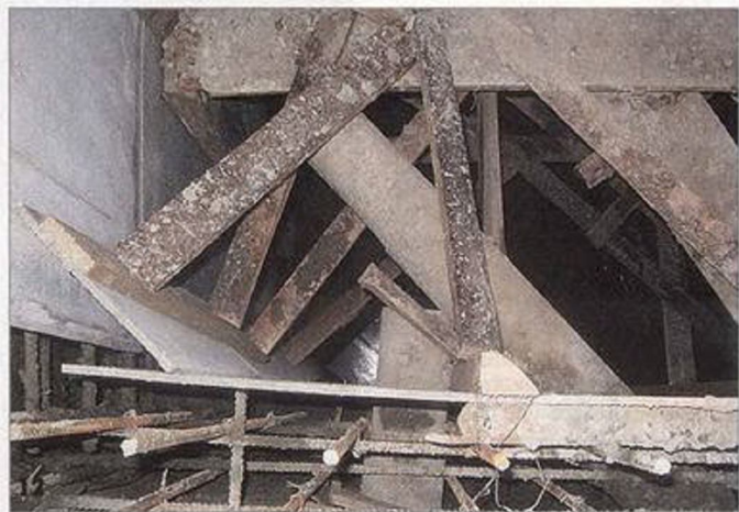
Опалубка септика. Скошенные углы — для укрепления конструкции.
