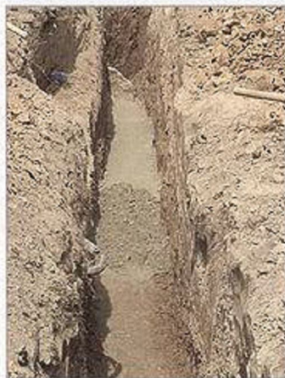
На дно траншеи уложена песчаная подушка.
