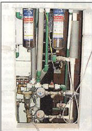
Шкаф-укрытие для стояка с подключёнными приборами закрывают декоративной стенкой с дверкой для удобства обслуживания.
