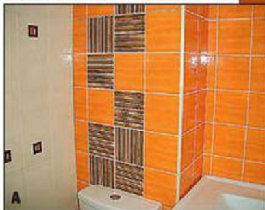
Глядя на стены ванной комнаты (фото слева), не скажешь, что где-то здесь есть люк для доступа к сантехническим приборам.
