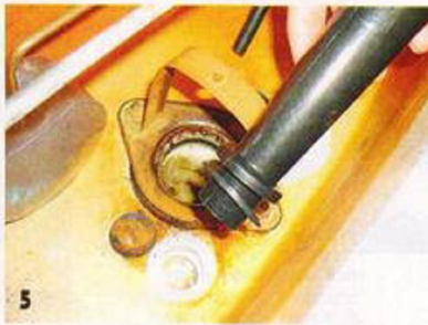
Теперь нужно прикрутить переливную трубку.
