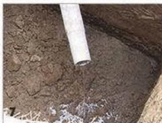
Проверка уклона труб.
