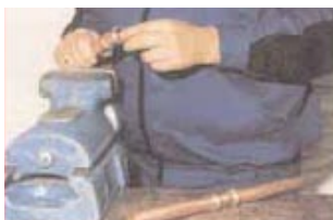
c) Verificarea poziției inelului O. Nu se va folosi ulei, unsoare sau lubrifianți !
