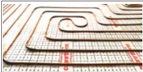
Fig. 36 Încălzire în pardoseală, realizată prin folosirea unei țevi de cupru cu înveliș din plastic, înainte ca țeava să fie acoperită cu șapa pardoselii finite. Dilatația termică a țevei va fi preluată de curbele serpentinei de țevi și de benzile de izolație termică plasate la curbe. Îmbinările de țeavă se realizează prin lipire tare sau prin presare.
