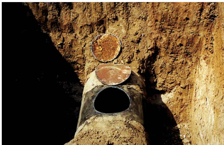
Рис. 2.10. Устройство лаза для контрольных замеров толщины стенок, макрошероховатости и степени зарастания внутренней поверхности водовода
