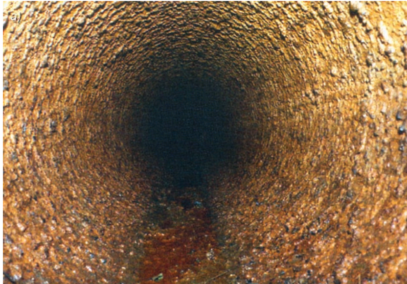
Рис. 1.1. Третий Краснопресненский водовод Москвы диаметром 1200 мм (сталь) время эксплуатации — более 30 лет (по данным С.В. Храменкова, «Мосводоканал»)
