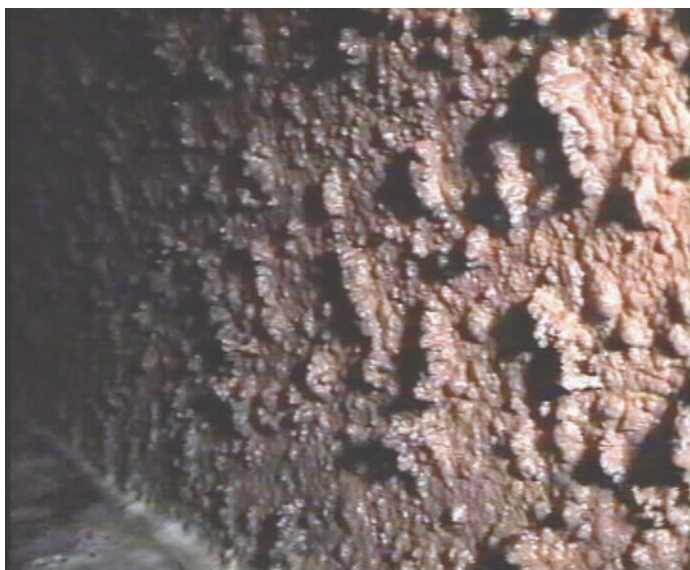
Рис. 3.9. Макрошероховатость внутренней поверхности водовода диаметром 1200 мм (время эксплуатации водовода 37 лет)
