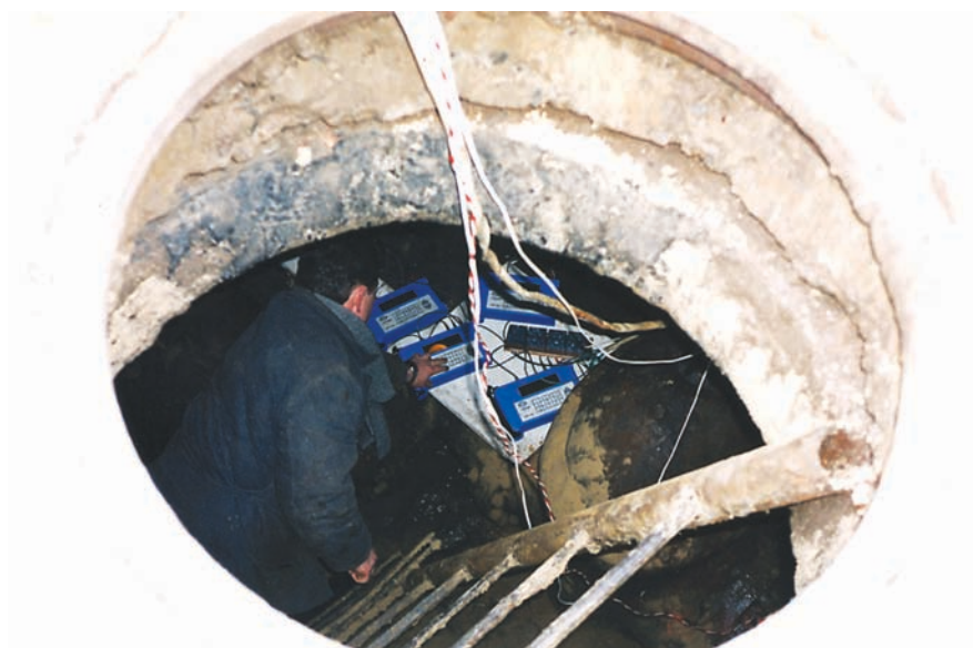
Рис. 2.15. Монтаж приборов учета расхода воды типа UFM 610 р в колодце контрольного пункта по ул. Ахсарова (Харьков)
