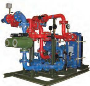
Проектируются для зависимых и независимых схем присоединения систем отопления, вентиляции и кондиционирования, для закрытых и открытых систем теплоснабжения с обратным циркуляционным трубопроводом ГВС или без него (тупиковая схема).
