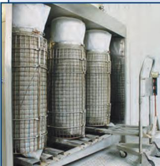
Иловые фильтры предназначены для обезвоживания и упаковки осадка, образующегося на очистных сооружениях, до 80% уровня влажности.
