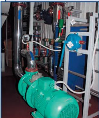
Предназначены для аварийного снабжения потребителей тепла, с возможностью неоднократной перевозки любыми видами транспорта (автомобильным, железнодорожным, авиационным).
