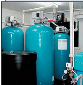
Промышленные установки применяются для обработки потоков воды по заданным параметрам (котельные, объекты теплоэнергетики, ЖКХ и различных отраслей промышленности).
