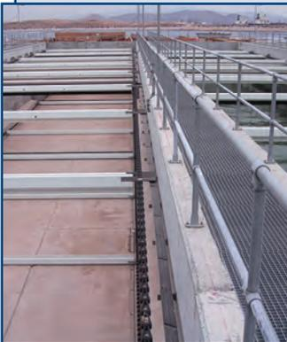
Производство различных типов скребковых систем Finnchain (Финляндия) для сбора донного илового осадка, плавающих веществ и песка. Область применения – водопроводные и канализационные очистные сооружения.
