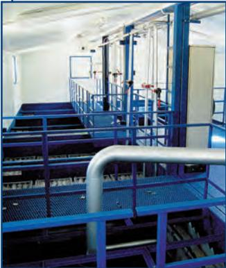
Компактные автоматизированные блочно-модульные станции ЁРШ® биологической очистки сточных вод предназначены для приема и глубокой очистки хозяйственно-бытовых и близких к ним по составу сточных вод, поступающих от малых населенных мест, гостиничных и туристических комплексов, вахтовых рабочих поселков, коттеджных и дачных поселков, жилых комплексов. Работают с применением классической технологической схемы очистки с дополнительным блоком биологической доочистки и двумя ступенями фильтрации.
