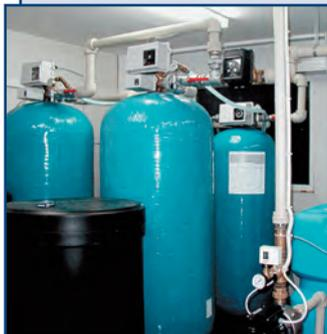
Промышленные установки применяются для обработки потоков воды по заданным параметрам (котельные, объекты теплоэнергетики, ЖКХ и различных отраслей промышленности).
