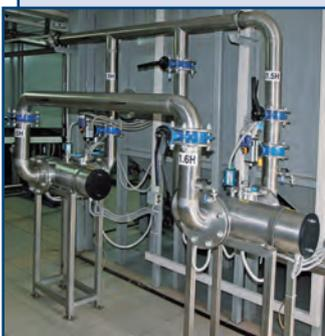
Установки предназначены для обеззараживания воды питьевого и технологического пользования, очищенных сточных вод.
