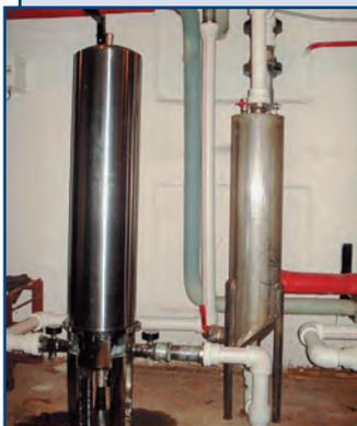
Предназначена для эффективной очистки различных потоков воды (сетевой, подпиточной, оборотной, сточной и др.) от механических взвешенных примесей размером более 10 мкм. Может применяться на объектах ЖКХ (вводы холодной и горячей воды в жилые дома, котельные и ТЭЦ, промышленные предприятия) для обеспечения требуемого качества воды.
