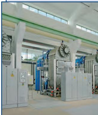
Оборудование предназначено для обеззараживания воды в высокопроизводительных системах водоподготовки предприятий ЖКХ, энергетического хозяйства, промышленности и др. Разработаны 3 серии оборудования (К, В, Е) для различных диапазонов УФ-пропускания воды.
