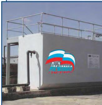
Предназначены для очистки сточных вод до нормативов сброса в водоемы питьевого и рыбохозяйственного назначения. Полученный в процессе очистки осадок подвергается минерализации с последующим механическим обезвоживанием или вывозом на иловые площадки.
