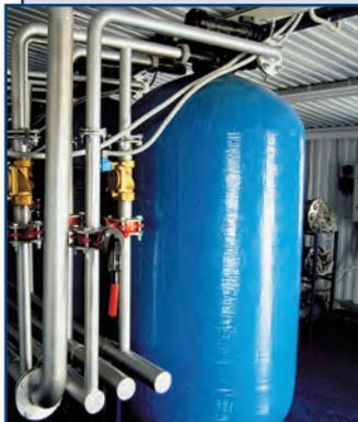
Проектирование и производство станций водоподготовки ВОС для приема и очистки малозагрязненных природных подземных вод до показателей качества очищенной питьевой воды согласно СанПиН 2.1.4.1074. Производительность автоматизированных блочно-модульных станций водоподготовки ВОС – от 50 до 800 м<sup>3</sup>/сут, рассчитывается в зависимости от состава и режима поступления исходной воды из источника.
