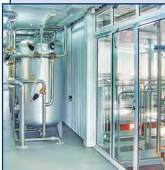
Установка предназначена для очистки хозяйственно-бытовых и близких к ним по составу промышленных сточных вод с доведением показателей качества очищенной воды до нормативов сбросов в рыбохозяйственные водоемы.
