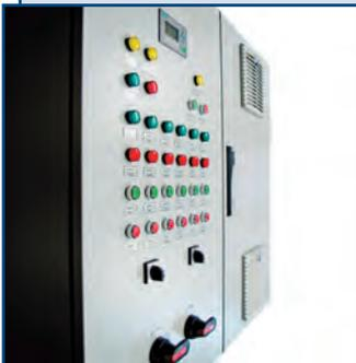
Системы частотного регулирования (СЧР) предназначены для управления работой насосных агрегатов и другого оборудования систем водоснабжения и водоотведения. СЧР осуществляют автоматизацию работы агрегатов, оснащенных трехфазными асинхронными электродвигателями, посредством регулирования частоты вращения с помощью преобразователей частоты в соответствии с требуемыми алгоритмами работы. Разработка и изготовление СЧР в соответствии с техническим заданием.
