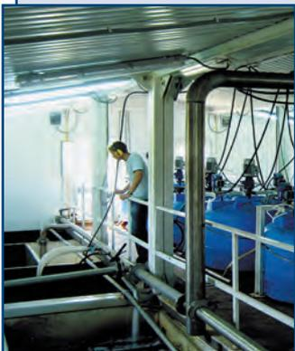
Блочно-модульные станции ЁРШ® биохимической (физико-химической) очистки сточных вод предназначены для приема и глубокой очистки сточных вод (низкоконцентрированных; смешанных или сточных вод, состав которых значительно колеблется при суточных и сезонных колебаниях) до нормативов, предъявляемых к выпуску в рыбохозяйственные водоемы 1-й категории.
