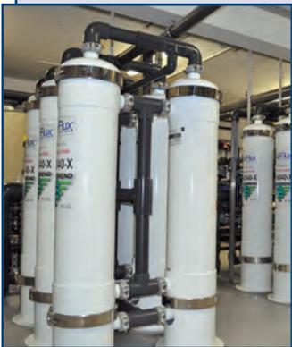
Liqui-Flux® – наиболее экономичные среди всех существующих модулей ультраfiltrации: площадь поверхности мембраны стандартного модуля 75 м<sup>2</sup>.
