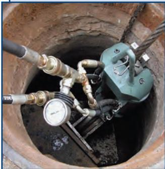
Компактные и удобные в работе тросовые установки для замены трубопроводов с разрушением старой трубы. Предназначены для замены старых труб из стали, чугуна, асбеста, керамики на новые трубы из полиэтилена, с разрушением старой трубы, с увеличением диаметра. Все установки сконструированы исходя из возможности работы в колодце для труб, резервуаров и поверхностей.
