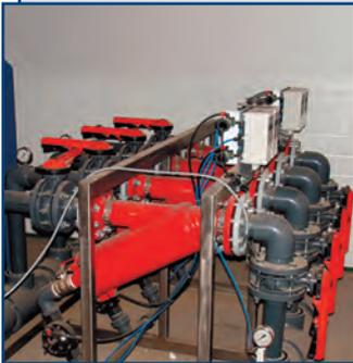
Автоматические самоочищающиеся фильтры AMIAD предназначены для удаления из воды механических загрязнений. Применяются в котельных, системах охлаждения, градирнях, на водозаборах; для предварительной фильтрации перед станциями водоочистки и т. д.
