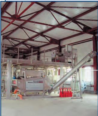
Станции биологической очистки (СБО) предназначены для локальной биологической очистки бытовых сточных вод в соответствии с нормами и правилами для сброса сточных вод в окружающую среду или повторного использования.
