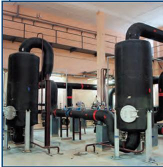
Предназначен для очистки сетевой, подпиточной, оборотной воды от механических примесей (плотность – выше 1 г/см<sup>3</sup>, размер – более 50 мкм) для котельных и ТЭЦ, в тепловых сетях, водооборотных системах предприятий. Гидродинамический принцип улавливания механических примесей.
