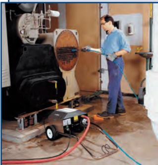
Очистители труб, котлов и теплообменных аппаратов General Industrial (США) – это механические устройства с пневмо- или электроприводом, сверлами, щетками и специальными приспособлениями для очистки любых труб (в т. ч. и U-образных).
