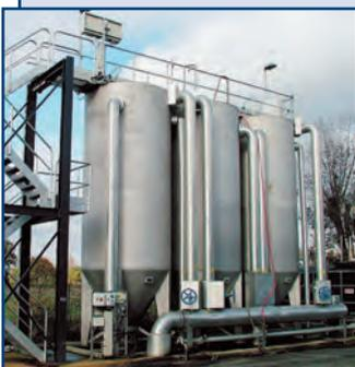
Контактные фильтры непрерывного действия DynaSand применяются на муниципальных и промышленных предприятиях для процессов очистки. Назначение:
