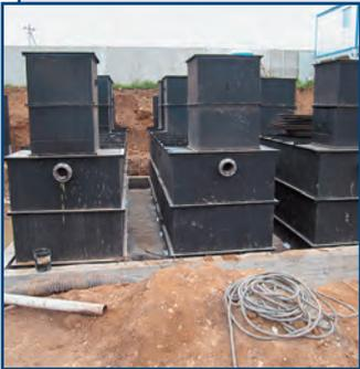
Предназначена для очистки поверхностных нефтесодержащих стоков, устанавливается на дождевом выпуске.
