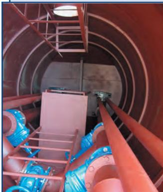
КНС предназначены для перекачки хозяйственно-бытовых, ливневых и производственных сточных вод.
