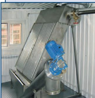
Устройство фильтрующее самоочищающееся предназначено для отделения включений до 2 мм из сточных вод.
