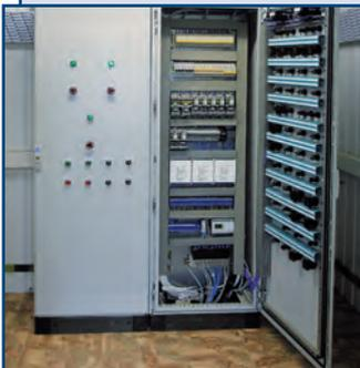
Автоматизированная система предназначена для эффективного контроля и управления, в т. ч. дистанционного, технологическим оборудованием.
