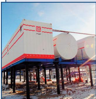
Мобильная установка в контейнерном исполнении предназначена для очистки воды из различных источников с целью получения питьевой воды и вод технологического назначения.
