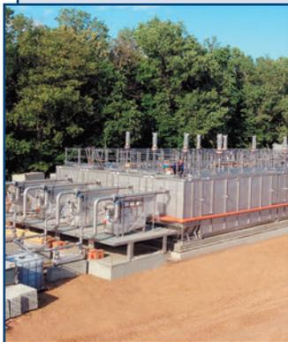
Блочно-модульные станции биологической очистки (СБО) обеспечивают очистку хозяйственно-бытовых сточных вод до показателей, соответствующих нормативным требованиям.
