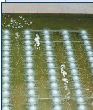
Аэрационные системы ОТТ широко применяются в коммунальных и промышленных очистных сооружениях и за счет инновационного решения позволяют увеличить их производительность.
