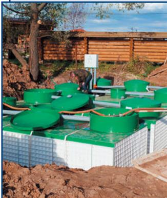
Модульная станция (полипропилен) подземной установки для очистки хозяйственно-бытовых и промышленных сточных вод. Сочетание биологической и физико-химической очистки позволяет получать гарантированные результаты по большому количеству параметров, а также значительно сократить размеры и стоимость очистных сооружений. Очищенный сток можно направлять в поверхностную ирригационную систему или водоем (при установке УФ). Производительность – 10–2000 м<sup>3</sup>/сут.
