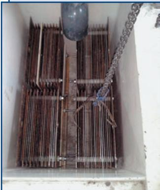
Коагулятор «Тритон» успешно применяется на очистных сооружениях шахтных вод и станциях водоподготовки питьевой воды. Конструктивно состоит из двух частей – источника питания (ИП) и электродного блока (ЭБ).
