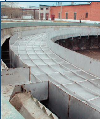
Отстойник-фильтр (патент № 29053) создается путем размещения фильтра с плавающей загрузкой непосредственно в проточной зоне отстойника.
