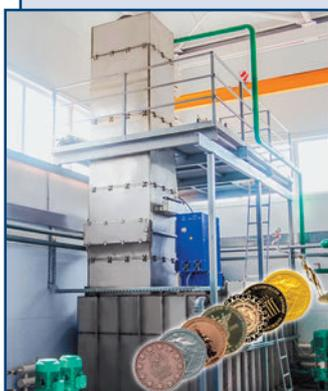
Предназначен для очистки воды из подземных источников до качества, соответствующего требованиям СанПиН 2.1.4.1074-01 «Питьевая вода и водоснабжение населенных мест», придания воде вкусовых качеств, соответствующих природным водам горных рек.
