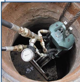
Компактные и удобные в работе тросовые установки для замены трубопроводов с разрушением старой трубы. Предназначены для замены старых труб из стали, чугуна, асбеста, керамики на новые трубы из полиэтилена с разрушением старой трубы, с увеличением диаметра. Все установки сконструированы исходя из возможности работы в колодце для труб, резервуаров и поверхностей.
