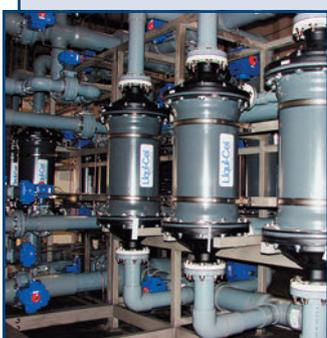
Мембранные контакторы Liqui-Cel® предназначены для дегазации жидкостей (альтернатива вакуумным дегазаторам, стриппер-колоннам и химическим уловителям кислорода):
