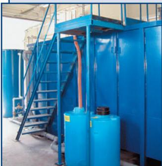
Обеспечивает очистку сточных вод до нормативов сброса в открытый водоем (взвешенные вещества – до 10 мг/л, БПК полн. – до 3 мг/л).
