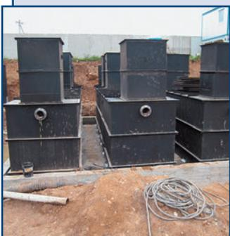
Предназначена для очистки поверхностных нефтесодержащих стоков, устанавливается на дождевом выпуске.
