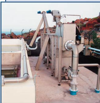
Комбинированные установки состоят из механической решетки (тип подбирается исходя из состава стоков), пескоуловителя, жируловителя и уплотнителя отходов. Обеспечивают комплексную механическую очистку стоков в одном технологическом узле. Мусор и песок дополнительно уплотняются при выгрузке, что существенно сокращает объем отходов.
