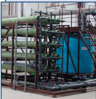
Установки предназначены для удаления из воды растворенных веществ.
