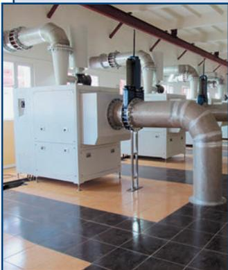
Турбовоздуходувки на бесконтактной опоре – компактное, экономичное воздуходогагнетательное оборудование нового поколения, отличающееся низким уровнем шума, вибрации.
