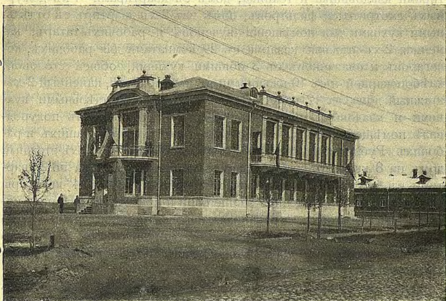
Зданіе конторы на Рублевской станціи.
