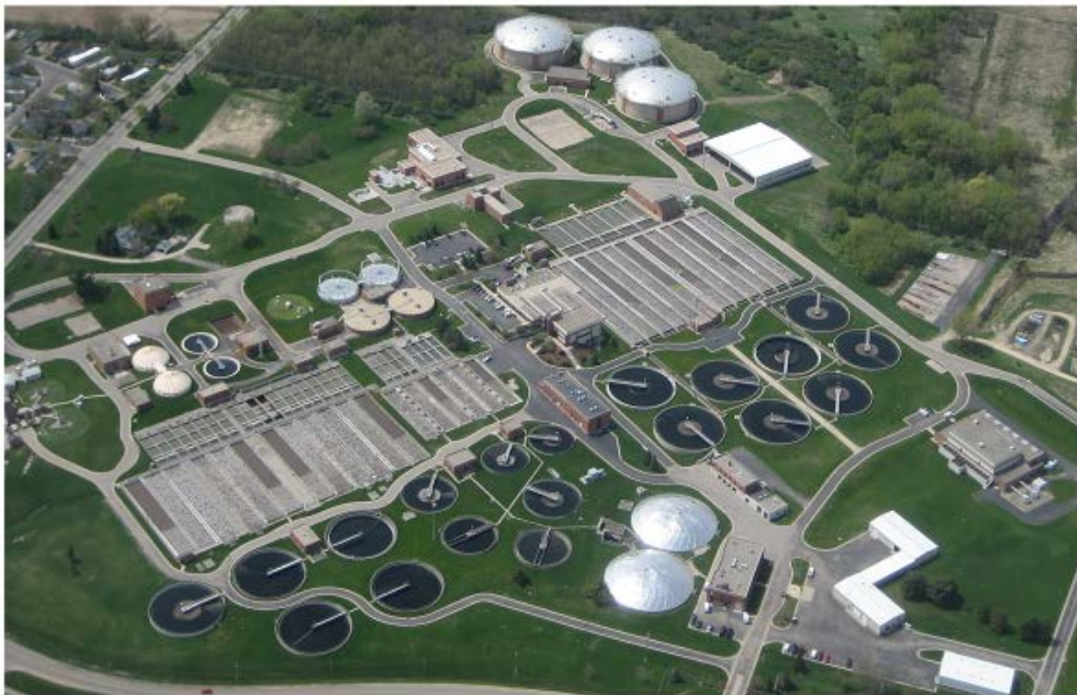
Statie de epurare moderna
