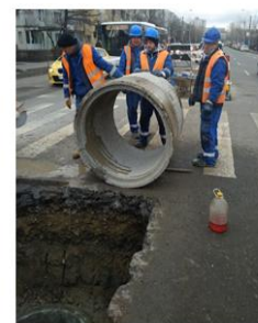
2. Lucrarea de remediere avarie la rețeaua de canalizare, din Bulevardul Primaverii a
