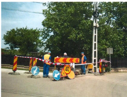
Foto nr.1 – Punctul de lucru mobil – camin de vizitare vana – apa potabila – str. Scolii, comuna Miroslava- reconstituire
