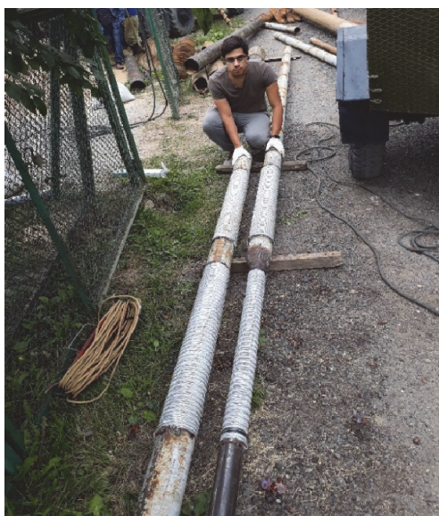
Рисунок 3. Фильтра экспериментальных скважин д. Приморье
