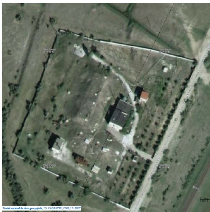
Фигура 4. Вид территории станции водоснабжения второго подъёма и хлораторной станции
