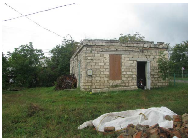
Figura 4. Clădirea stației de clorinare (stare nefuncțională)
