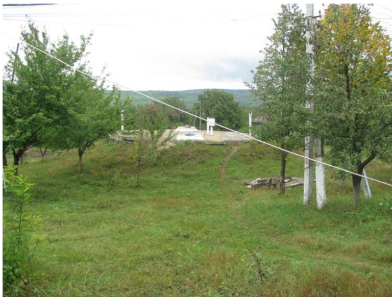
Figura 3. Stația de dezinfectare și de înmagazinare a apei
