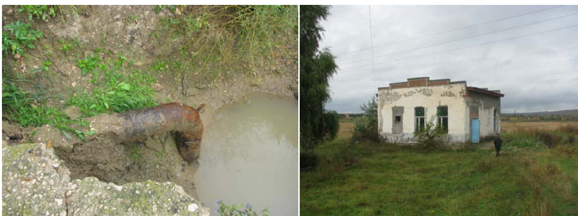
Figura 5. Clădirea stației principale de pompare a apelor uzate și colectorul sub presiune a apelor uzate
