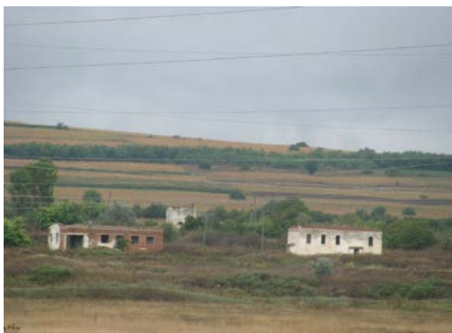
Figura 6. Construcțiile devastate ale stației de epurare
