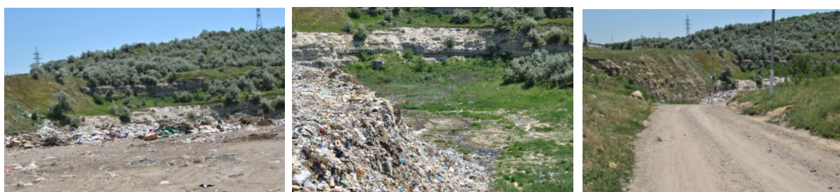
Figura 5. Imaginea depozitului actual
