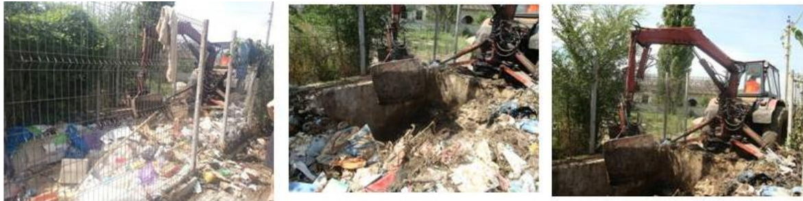
Figura 51: Colectarea deseuri de la platformele de tip inchis (Leova)
