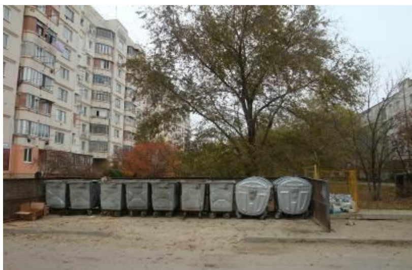
Figura 9: Platforma pentru colectarea deșeurilor menajere mixte (Cahul)
