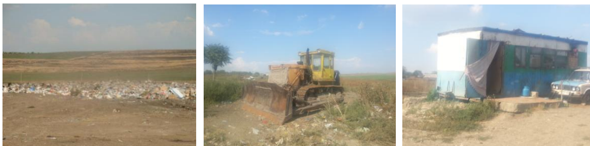
Figura 13: Imagini din interiorul gunoistei orasului Comrat
