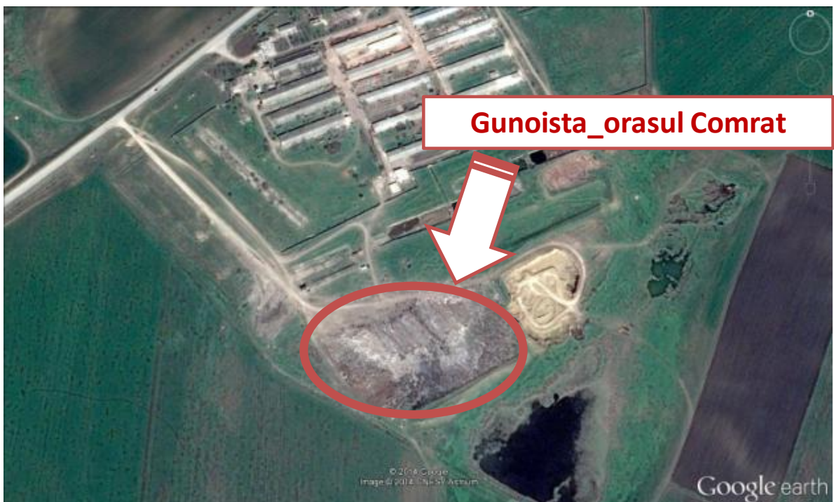
Figura 12: Locatia depozitului de deseuri (gunoista) Comrat
