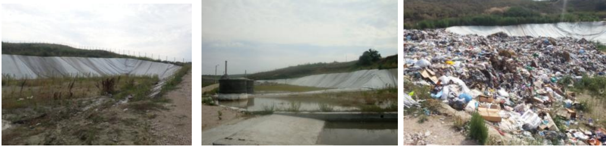
Figura 14: Imagini din interiorul depozitului de deseuri (Hincesti)
