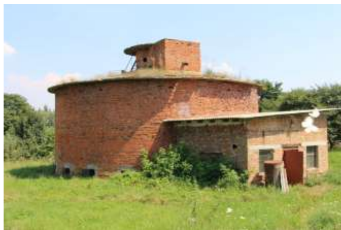
Figura 13. Vedere a filtrului biologic din exterior și din interior
