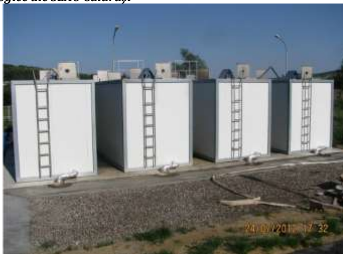
Figura 8 Reactoarele biologice ale SEAU Călărași
