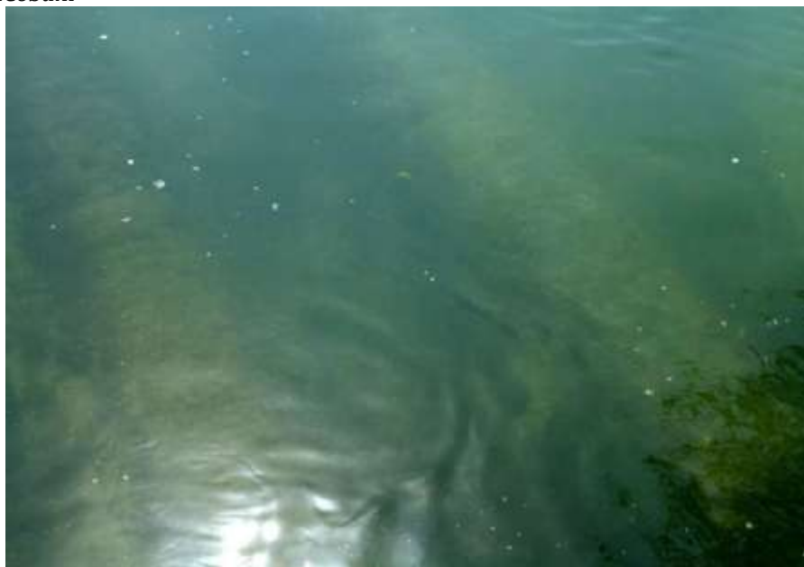
Figura 7. Calitatea apei râului Prut în zona captării. În apă se văd conductele de aspirație de la stația de pompare de treapta I din s.Cobani
