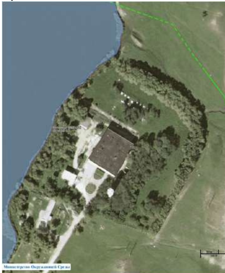
Figura 6 Stația de tratare apă brută din râul Prut
